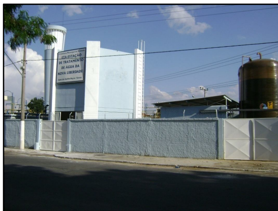
Figura 7 – ETA Nova Liberdade
