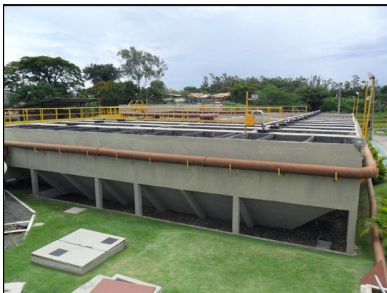
Figura 56– Reator UASB e biofiltro aerado.
