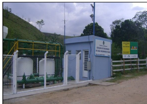
Figura 31 – Vista da ETA Engenheiro Passos
