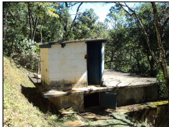
Figura 51 – Unidade de reservação
