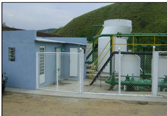
Figura 30 – Acesso a ETA Engenheiro Passos
