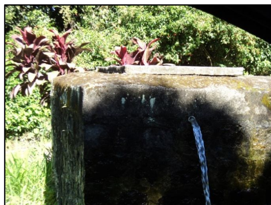
Figura 47 – Unidade de reservação
