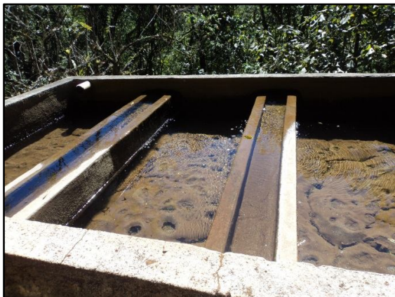
Figura 50 – Unidade de filtração
