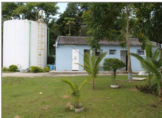
Figura 23 – Vista da ETA São Caetano
