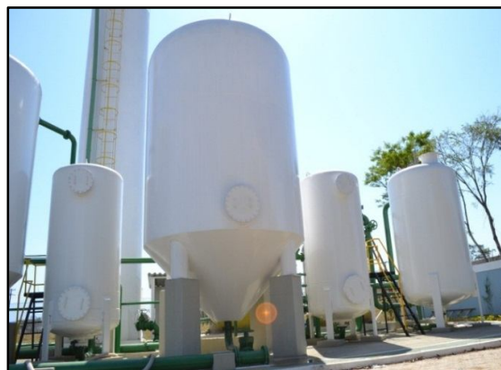
Figura 21 – Unidades de tratamento
