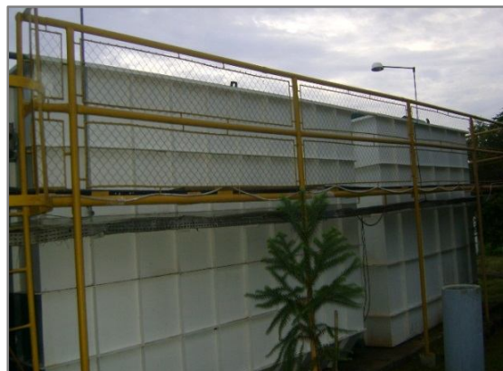
Figura 24 – Unidade de tratamento
