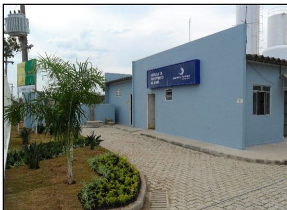
Figura 20 – ETA Fazenda da Barra
