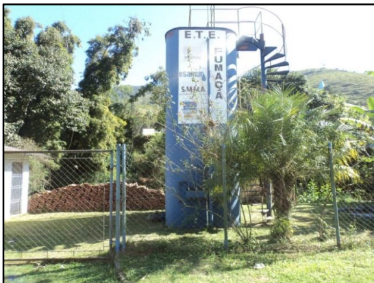
Figura 67 – Vista da ETE do distrito de Fumaça
