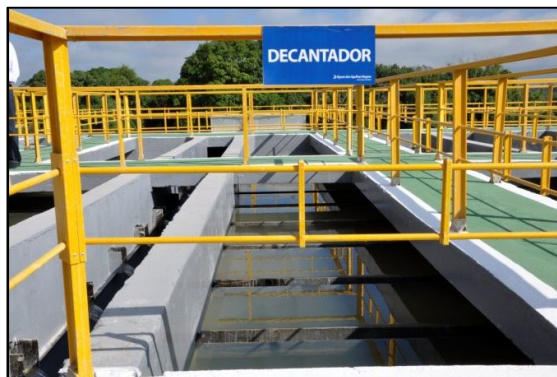
Figura 12 – Decantador do novo módulo - ETA Alegria
