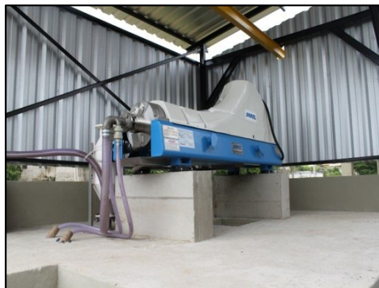
Figura 59 – Centrífuga de desidratação de lodo.
