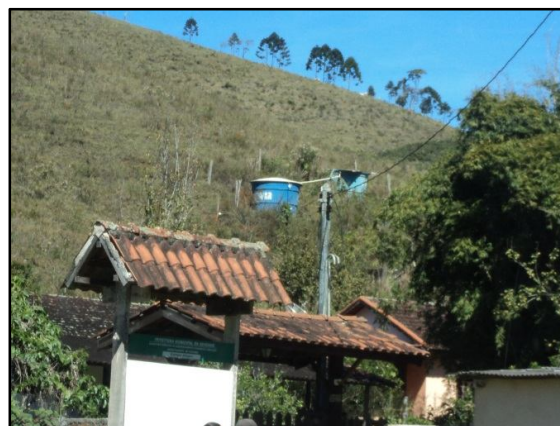
Figura 42 – Vista das unidades de reservação
