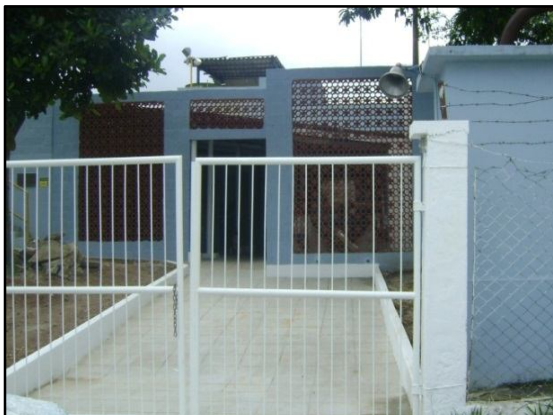
Figura 17 – Visão da entrada - ETA 31 de Março.
