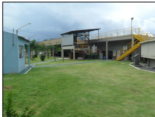
Figura 55 – Vista da ETE Alegria
