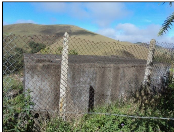
Figura 36 – Reservatório do distrito de Fumaça
