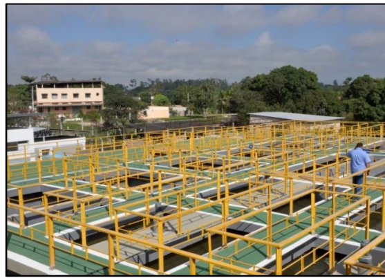
Figura 10 – Novo módulo da ETA Alegria
