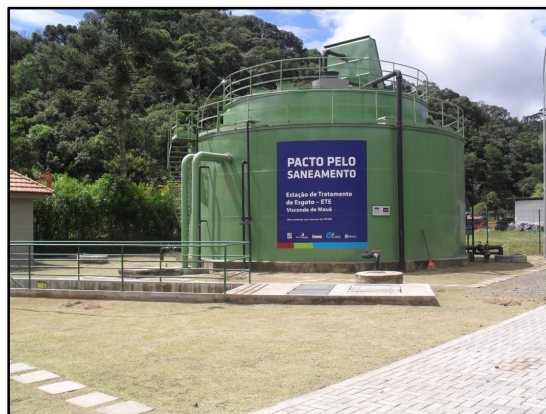
Figura 66– Unidade de Tratamento
