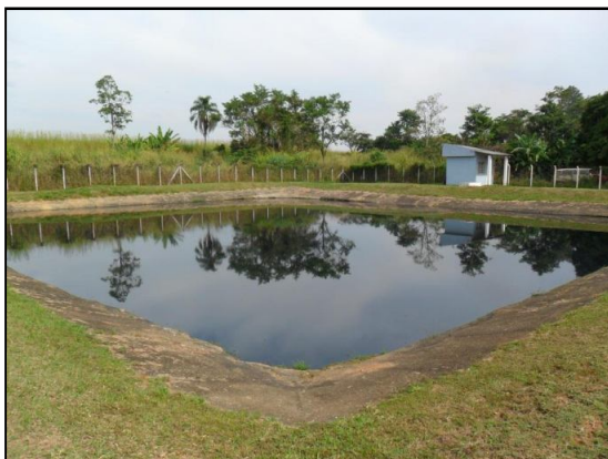
Figura 61– Lagoa anaeróbia da ETE Isaac Politi
