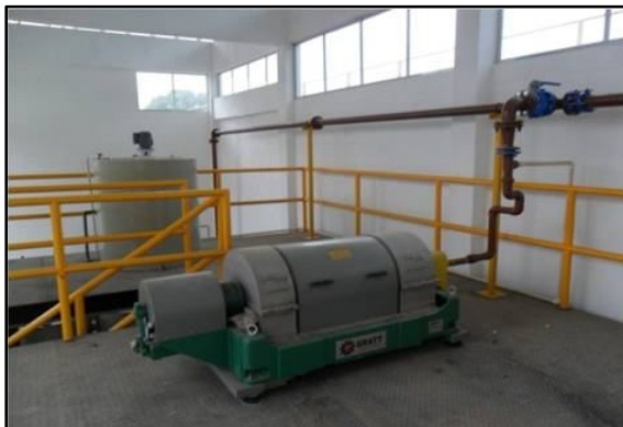
Figura 13 – Área de tratamento de lodo - ETA Alegria
