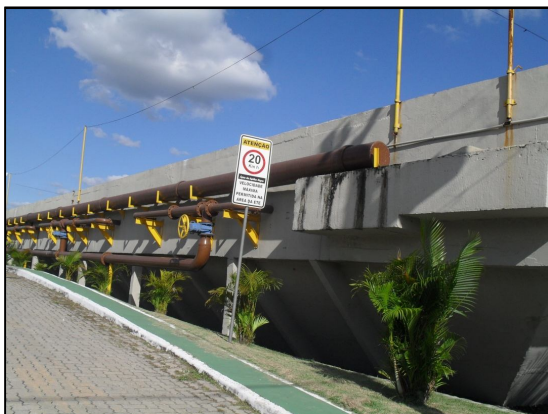
Figura 58– Vista da estrutura da ETE Alegria.
