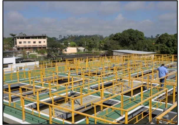
Figura 10 – Novo módulo da ETA Alegria
