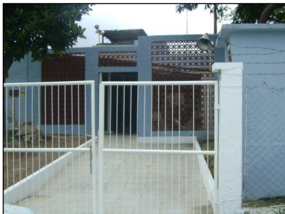
Figura 17 – Visão da entrada - ETA 31 de Março.
