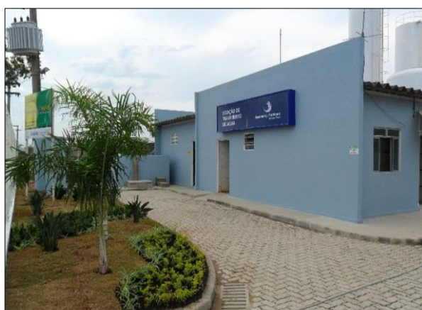
Figura 20 – ETA Fazenda da Barra
