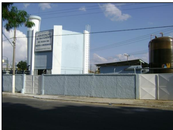
Figura 7 – ETA Nova Liberdade
