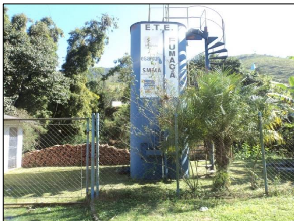
Figura 67 – Vista da ETE do distrito de Fumaça
