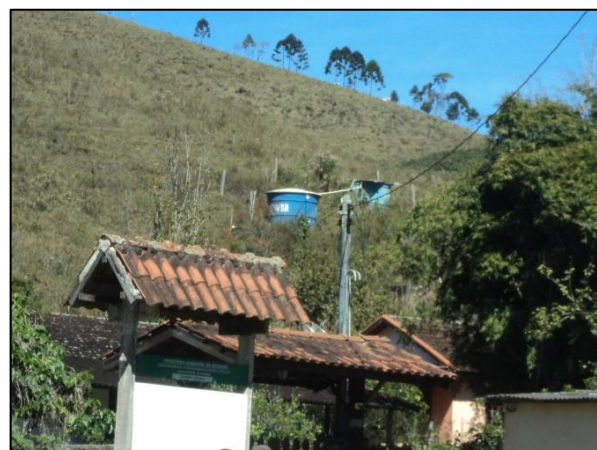
Figura 42 – Vista das unidades de reservação
